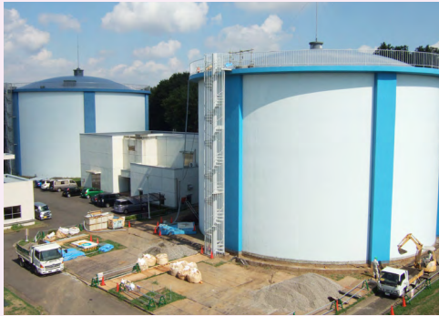
第1PC配水池耐震化工事の様子
